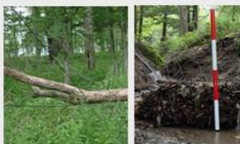
左:柵への倒木 右:土砂で埋まる柵 台風が直撃すると被害が増加する
